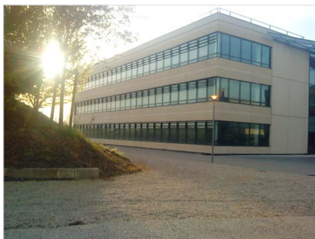
Département 94 : Protection contre la chaleur et l'éblouissement d'un ensemble de bureaux. Quantité : 324 stores
